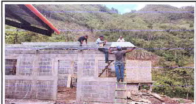
Foto 3: Rehabilitación de Pared
