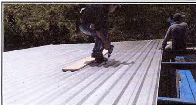
Foto 1: Sustitución de cubierta de láminas
