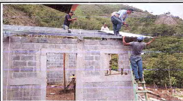
Foto 2: Rehabilitación de estructura de techo
