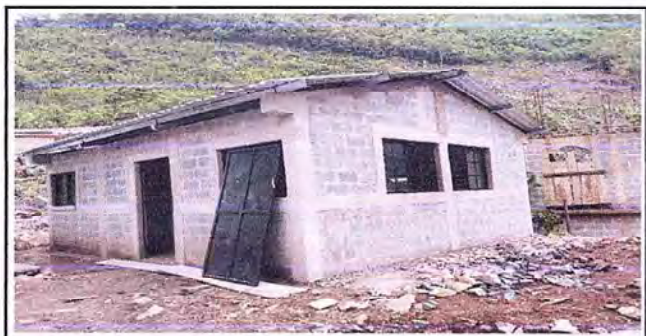
Foto 5: Sustitución de puertas
