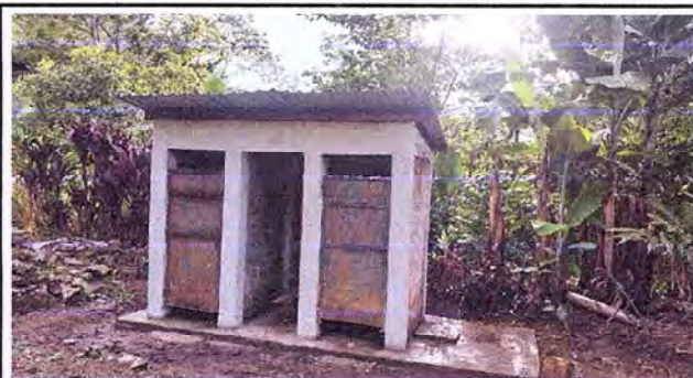
Foto 4: Rehabilitación de baño
